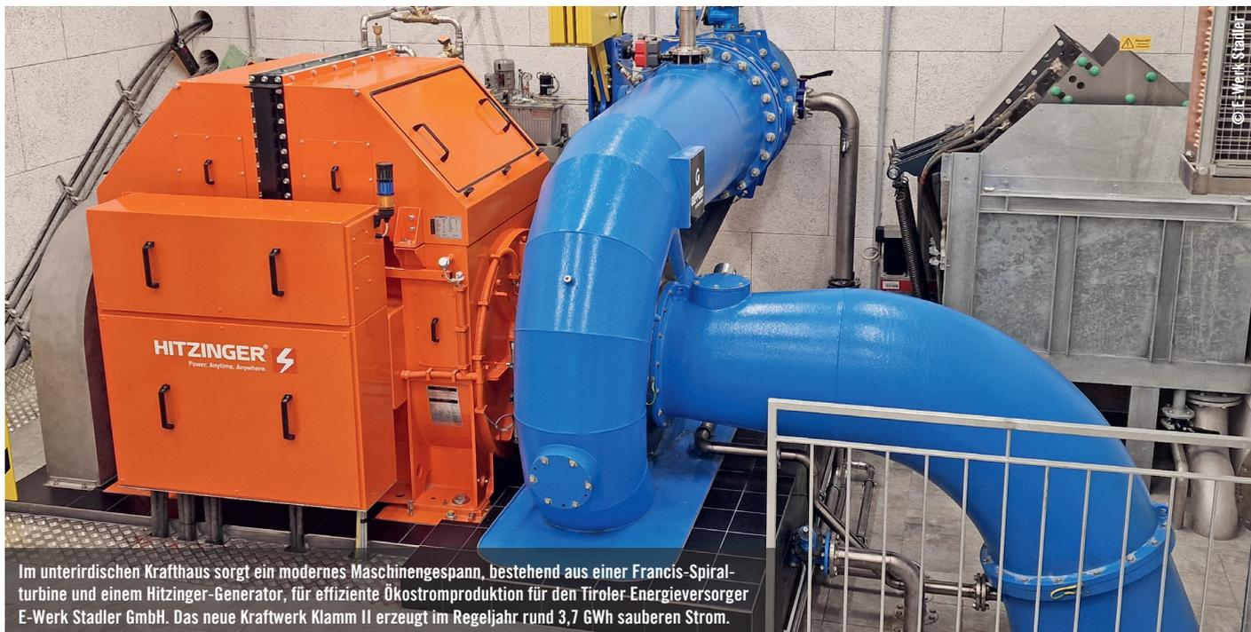
Im unterirdischen Krafthaus sorgt ein modernes Maschinenspann, bestehend aus einer Francis-Spiral-turbine und einem Hitzinger-Generator, für effiziente Ökostromproduktion für den Tiroler Energieversorger E-Werk Stadler GmbH. Das neue Kraftwerk Klamm II erzeugt im Regeljahr rund 3,7 GWh sauberen Strom.
