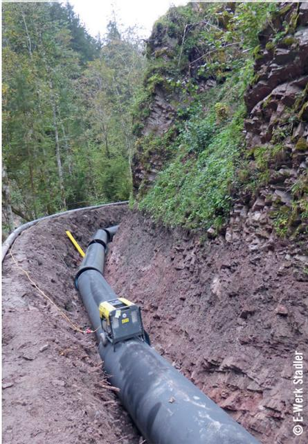
Über knapp 1,1 km wurde die Druckrohrleitung DN1000 in einen Wanderweg in der Klamm verlegt.
