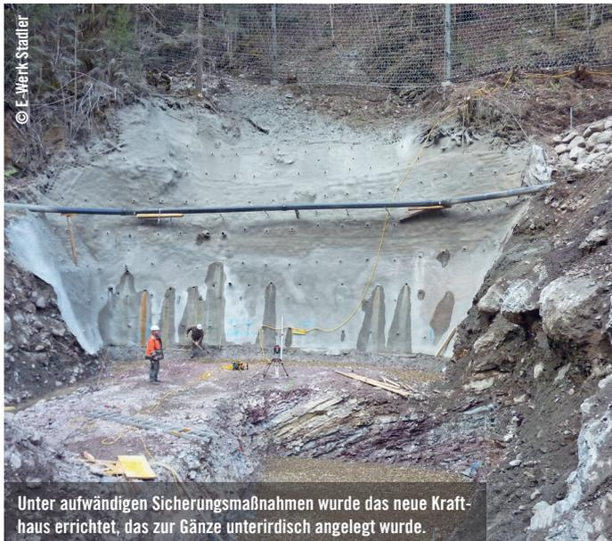
Unter aufwändigen Sicherungsmaßnahmen wurde das neue Krafthaus errichtet, das zur Gänze unterirdisch angelegt wurde.
