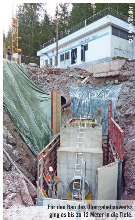
Für den Bau des Übergabebauwerks ging es bis zu 12 Meter in die Tiefe.
